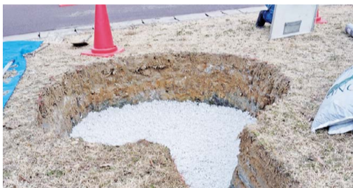
水はけを改善するため土壌改良剤を敷き、さらに手前に傾斜をつけている
