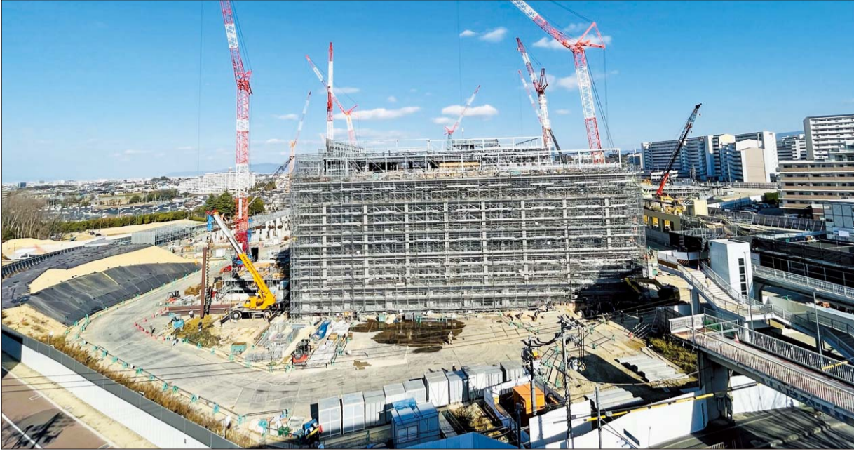
近大病院の外来棟(奥に診療棟など)、右手前の陸橋は新旧くぬぎ橋
