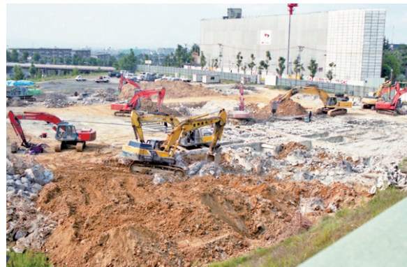
ホテル用地にあった鉄骨の撤去(三原台・9月)
