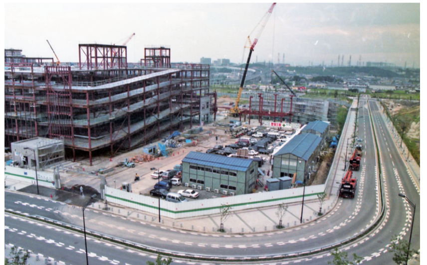
和泉中央駅前でエコール・いずみ本館が建設中(7月)
