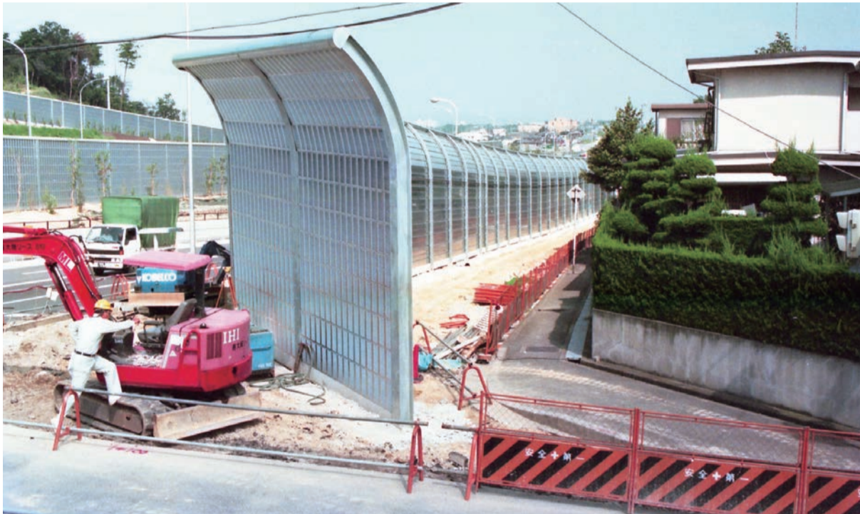
阪和道開通に合わせ騒音対策の遮音壁が完成、並走する泉北北線と二重構造(赤坂台・9月)
