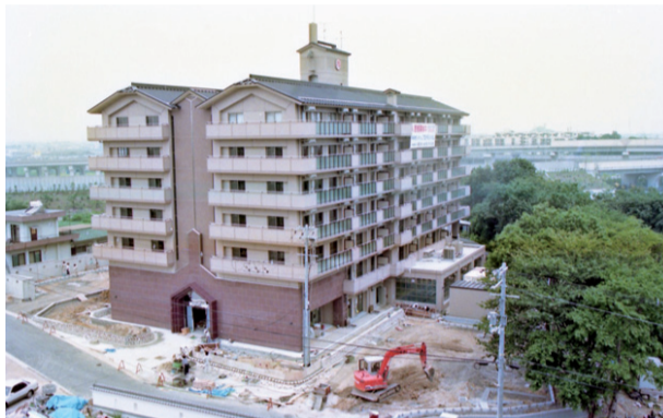
堺市初の有料老人ホーム、フロイデンハイムが完成(伏尾・10月) 高齢化社会に向け、施設の建設ラッシュが始まる
