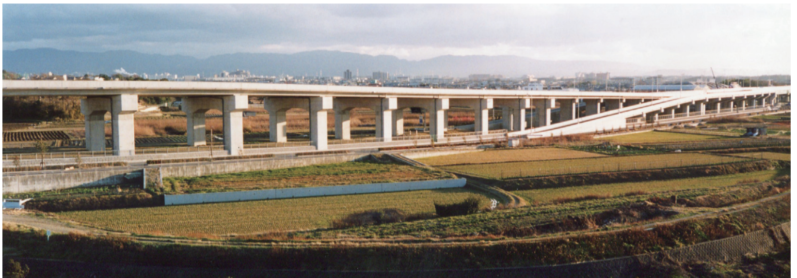
堺泉北有料道路が開通、当時は全区間通行料100円（小阪付近・3月）
