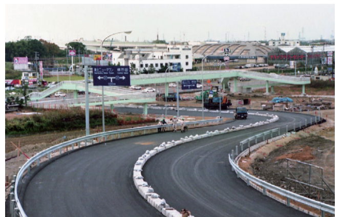
完成間近の堺インター接続道路（小代・12月）
