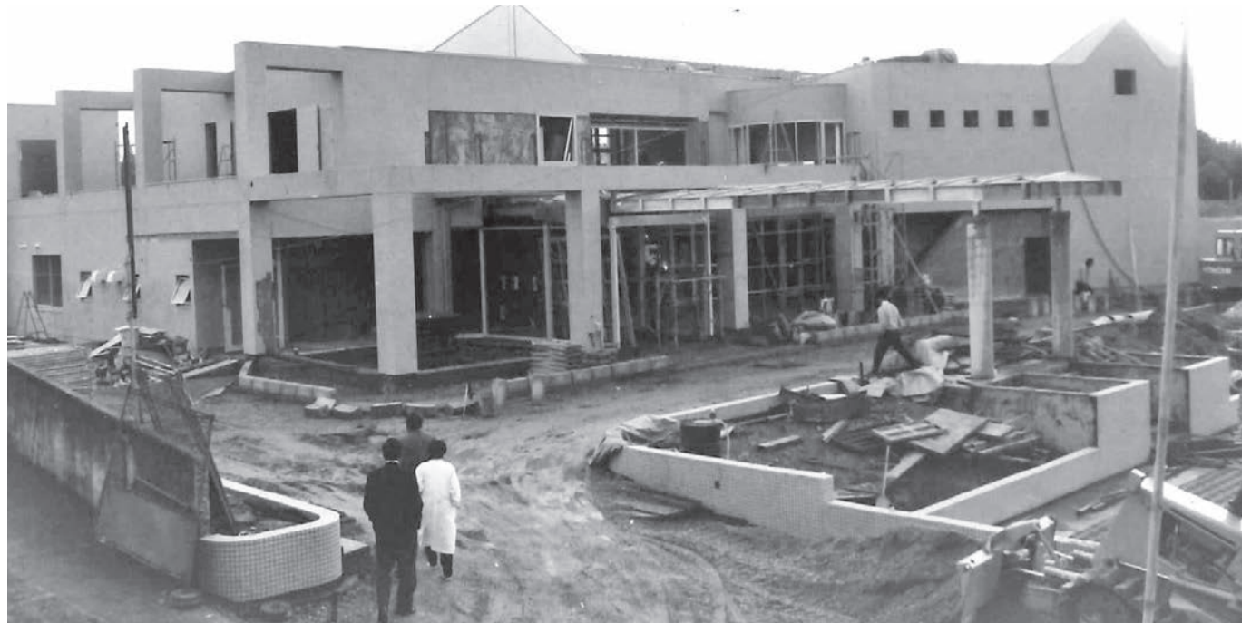
工事中の泉北急病診療センターが年末から稼働予定(竹城台・11月ごろ)
