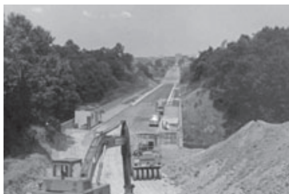
泉北南線の未開通部分が着工(7月) 後方は槇塚台
