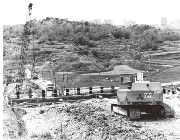
槇塚台から庭代台に向けて泉北南線の上神谷高架橋の工事始まる(4月)
