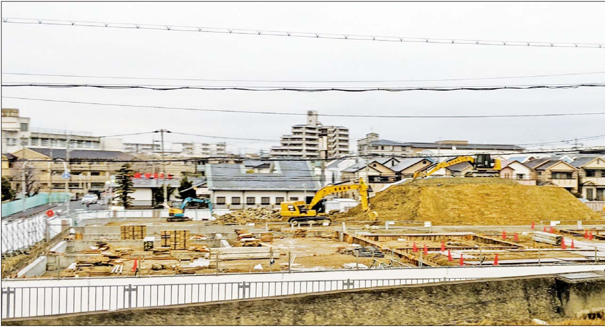
白いカバーで囲まれている建設予定地
