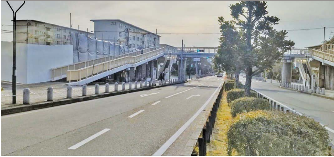
久野喜台二丁目バス停横の金剛第一歩道橋(左側はピュア金剛跡地)
