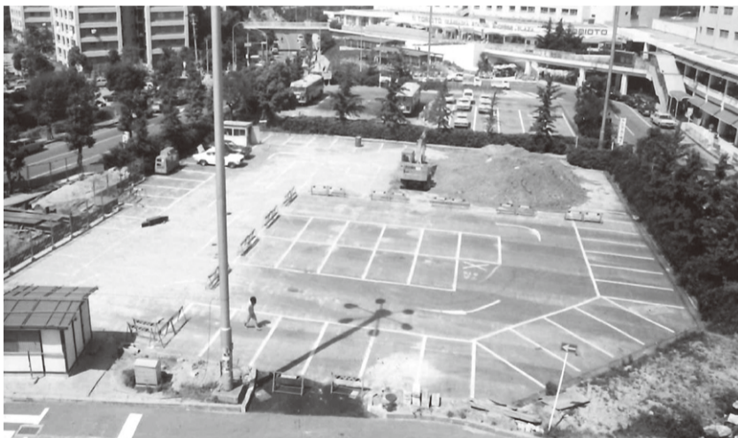
泉ヶ丘駅前第2駐車場立体化工事が始まる(6月)
