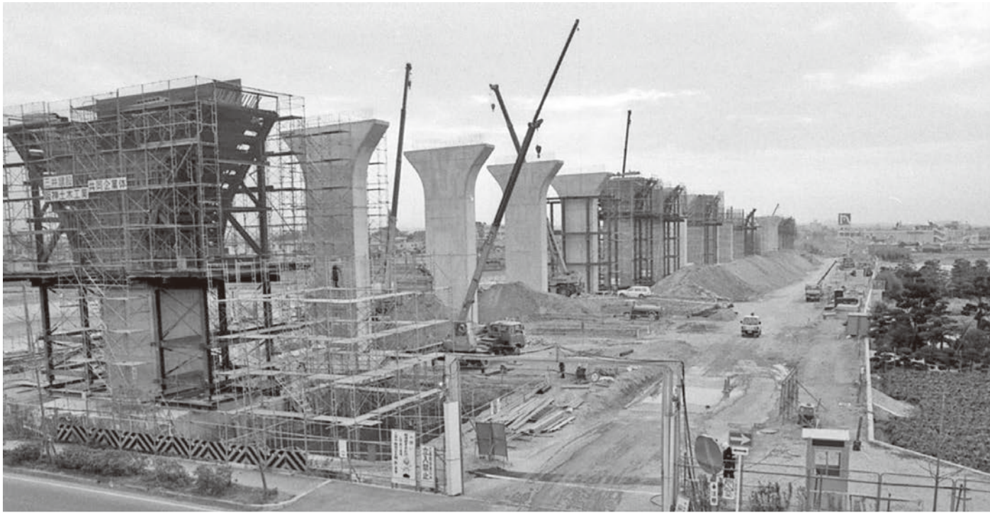
建設中の近畿道(東八田付近・7月)
