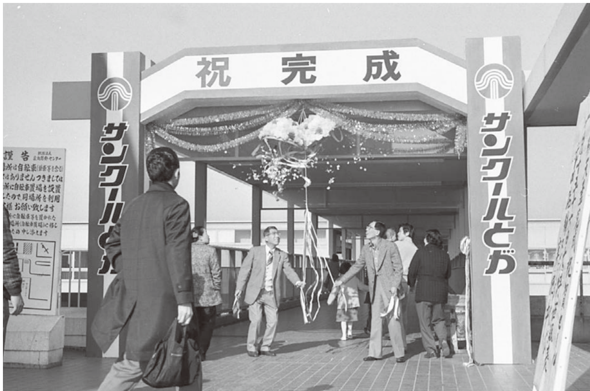
梅・美木多駅の陸橋に屋根が完成(1月)
