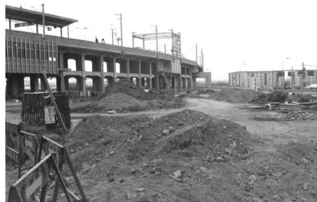
深井駅前のロータリー工事(3月)
