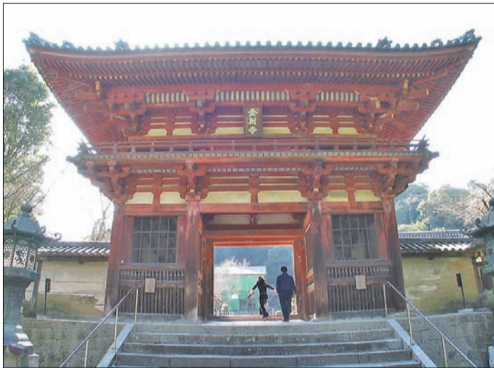
■天野山金剛寺…奈良時代に行基が開創し、弘法大師が密教の修業をした地と伝えられる。平安期、女性が弘法大師と仏縁を結ぶ霊場とされたことから、別名「女人高野」といわれる。
