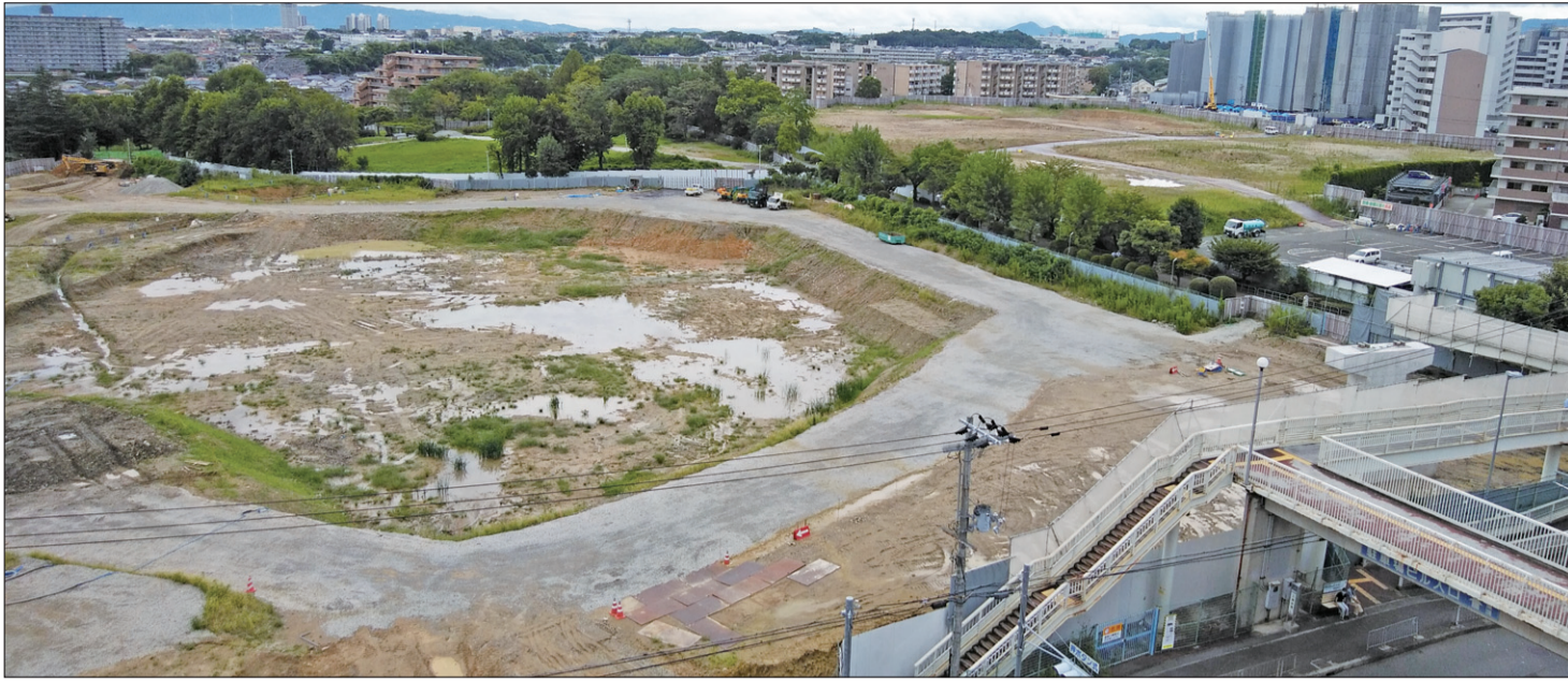
写真の左側が泉ヶ丘駅前の泉ヶ丘プール跡、右側が府営団地を撤去した跡(いずれも近大に売却)
