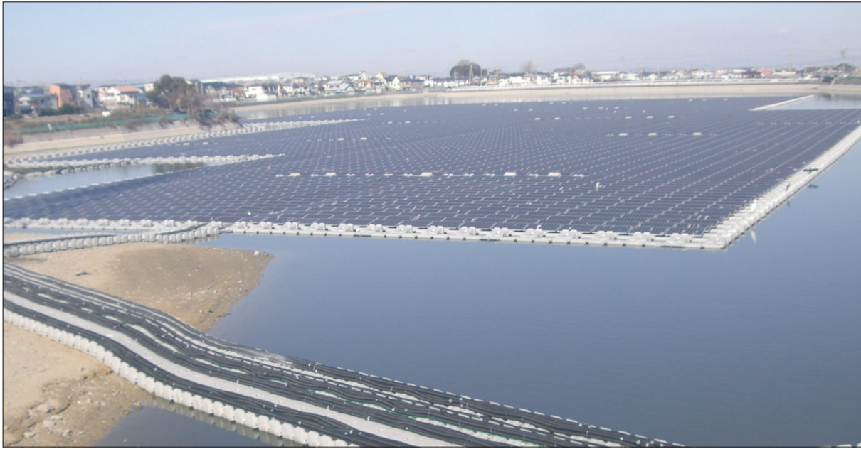
狭山市が設置した大鳥池の太陽光パネル
