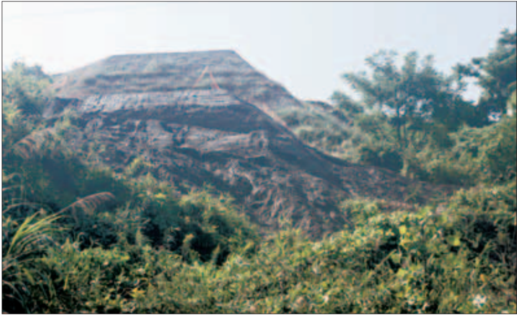
雨で積み上げた土砂が崩れ落ちている現場(10月12日撮影)
