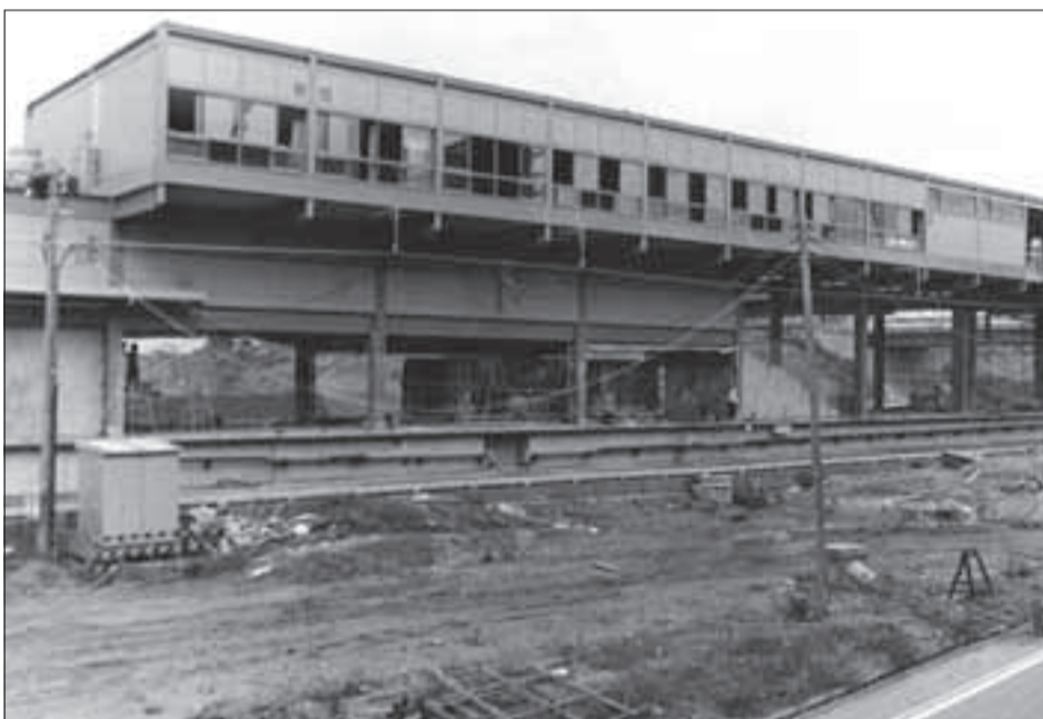
完成間近い梅・美木多駅(1973年10月)
