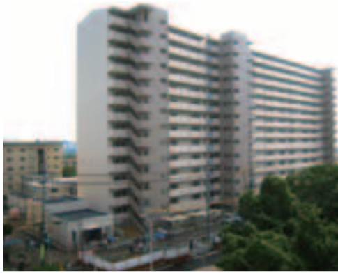
若松台に完成した14階建て府営住宅
