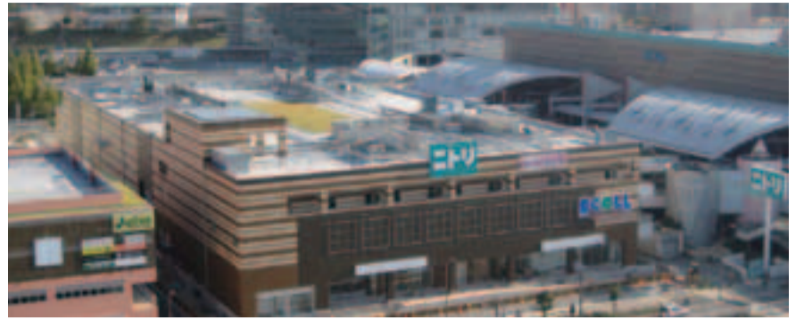
和泉中央駅前には次々と商業施設がオープン
